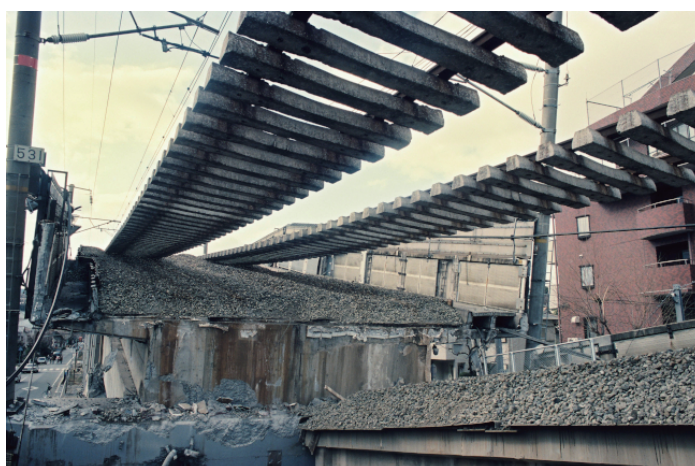
[ 朝日新聞 : 崩落した山陽新幹線の高架 ]
